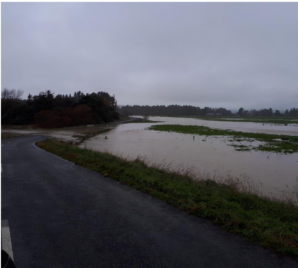
Pahautea Rd flooding
