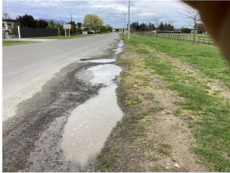
Edge break repairs
