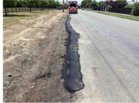
Edge break repairs
